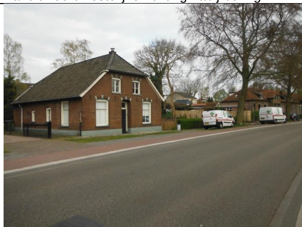
Vanuit zuidoostelijke richting
