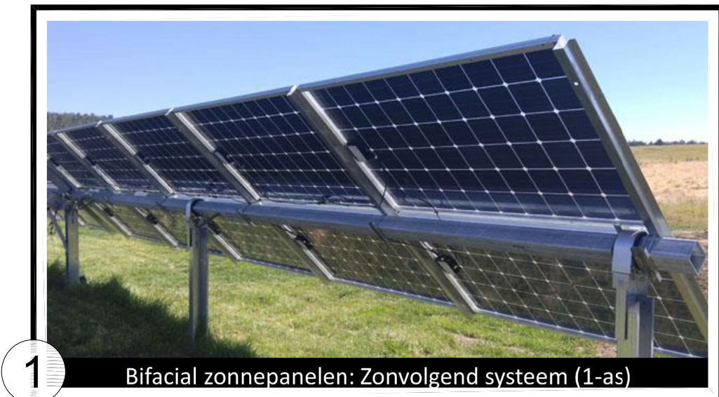
Bifacial zonnepanelen: Zonvolgend systeem (1-as)
