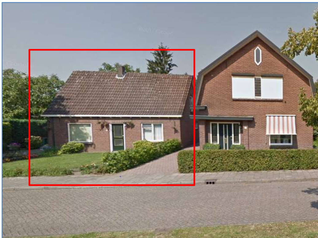
Figuur 6: foto van de huidige situatie ter plaatse, met in het rode kader de te slopen woning op de planlocatie.
