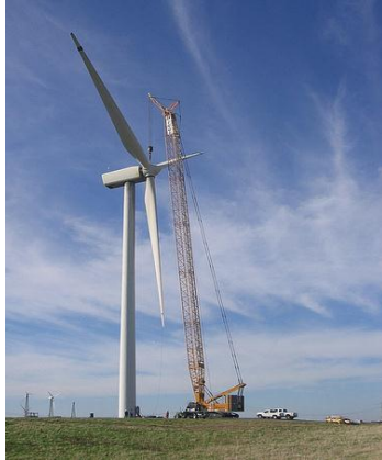
Figuur 4.2: Voorbeeld van een kraanopstelplaats nabij een turbine.
