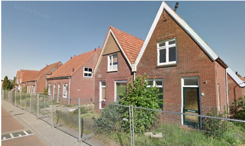
Afbeelding 4: woningen aan Vulcaanstraat voor de sloop (bron: Google maps)
