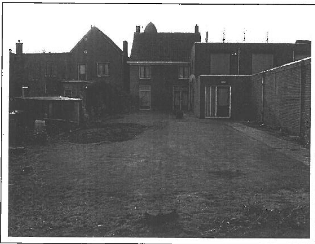
Foto 3. Achterzijde pand nr. 12
