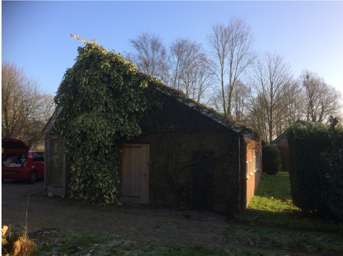
Afbeelding 8: bestaand situatie sanitairgebouw met logiesgebouw
