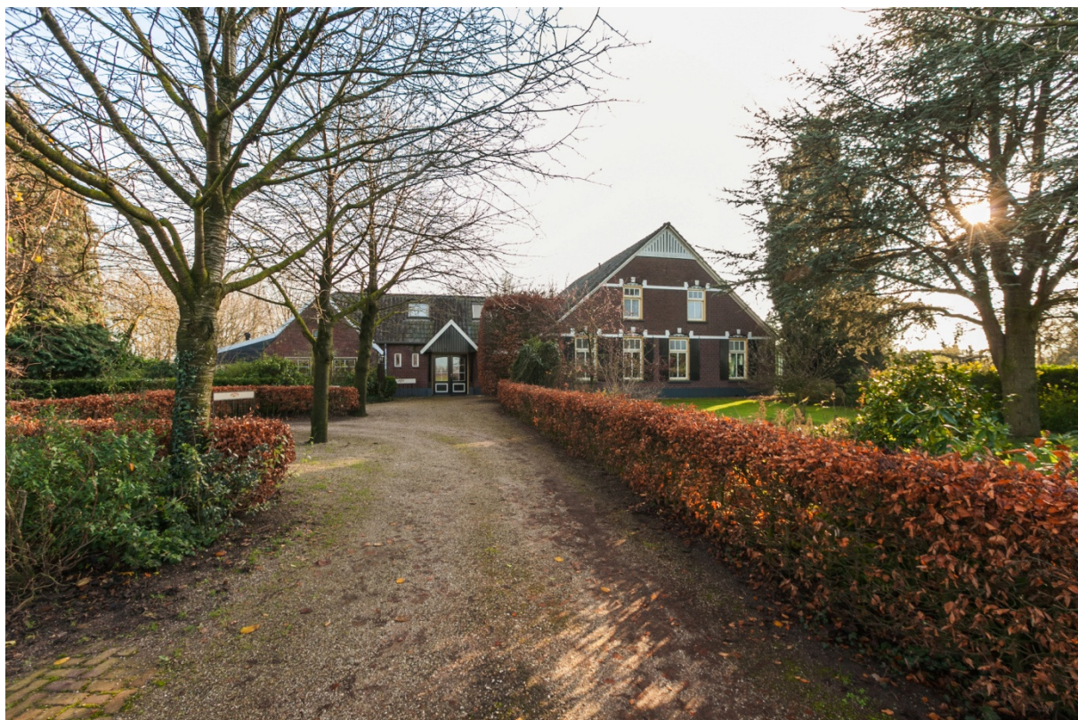
Afbeelding 4: aanzicht bestaande situatie entree hoofdgebouw vanaf Kasselderstraat
