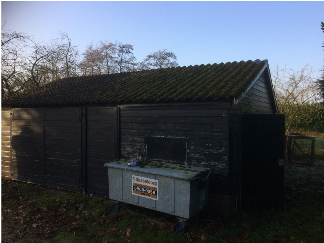
Afbeelding 9: bestaande situatie dierenverblijf met opslagruimte
