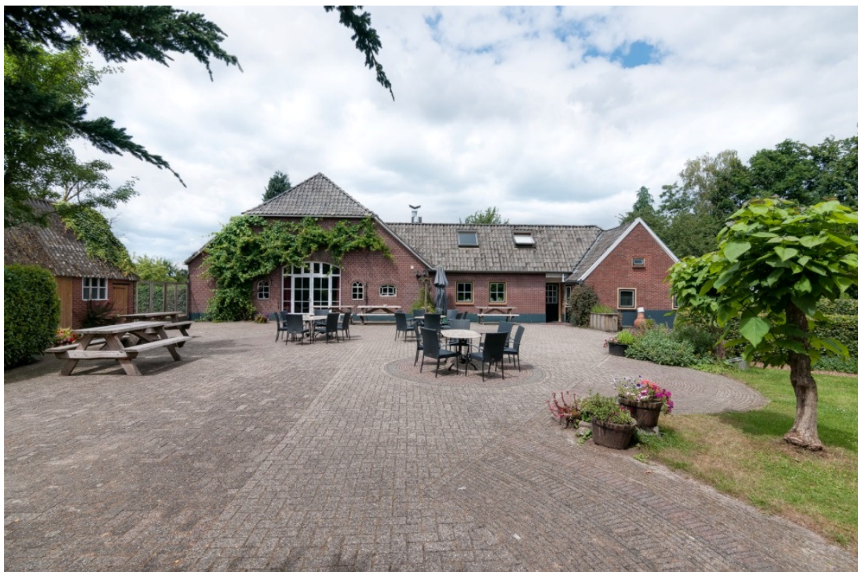
Afbeelding 6: bestaande situatie achterzijde hoofdgebouw
