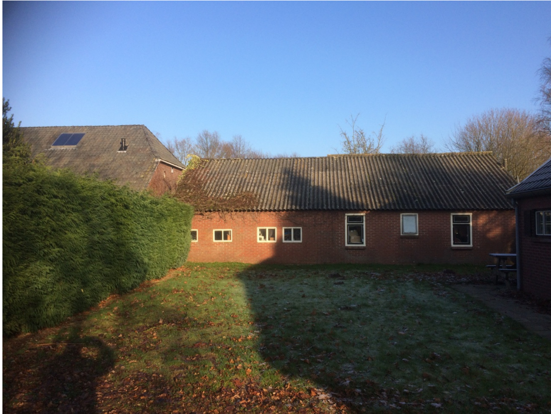
Afbeelding 10: bestaande situatie achterzijde sanitairgebouw (links) en logiesgebouw (rechts)
