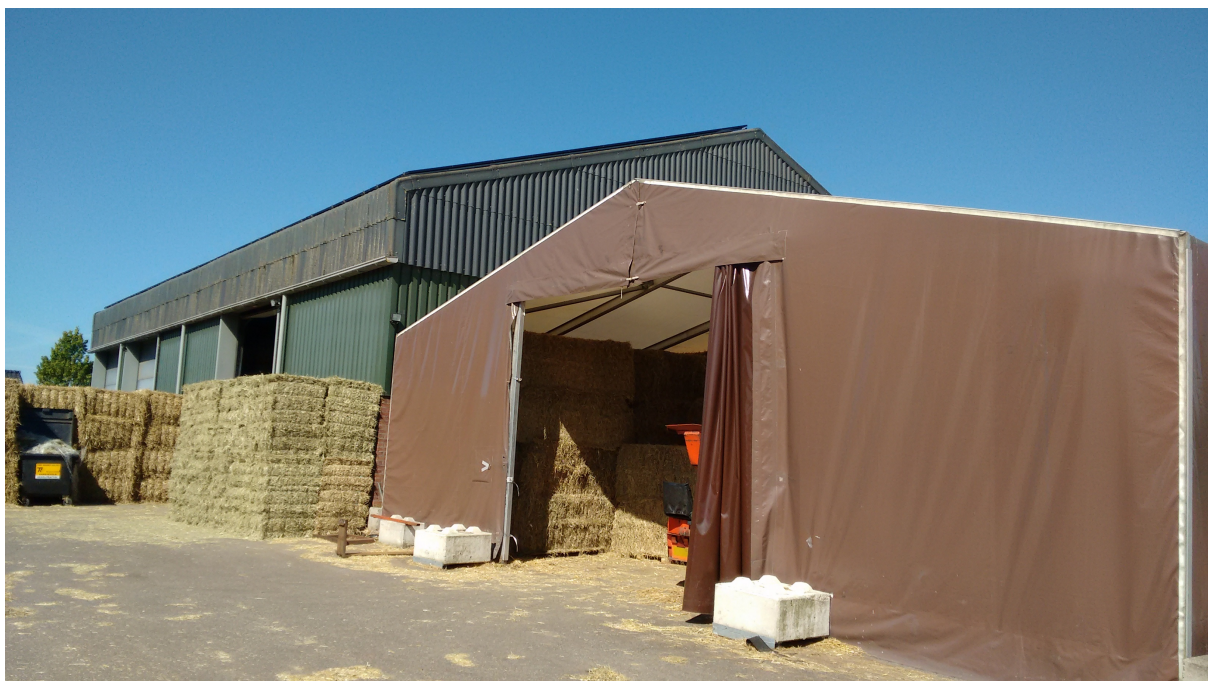
Afbeelding 7: de huidige permanente opslaghal met daarnaast de tijdelijke opslaghal met de tentconstructie
