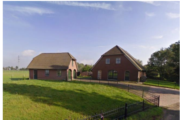
Zicht op het projectgebied richting het oosten. Links: Een van de bijgebouwen. Rechts: het linkerdeel van het hoofdgebouw (Google Maps)
