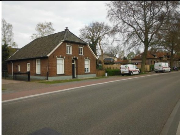
Vanuit zuidoostelijke richting
