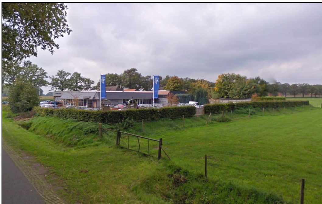
Figuur 8: zicht op planlocatie vanaf Kasselderstraat (bron: Google Maps)
