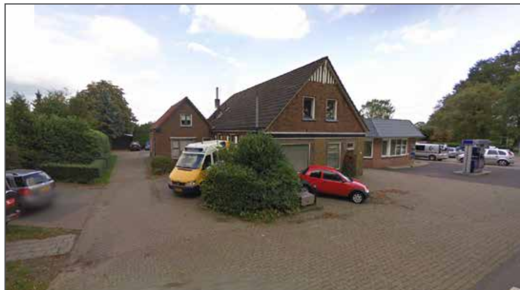
Foto: Zicht op het bedrijf met de te slopen bedrijfswoning (google streetview)
