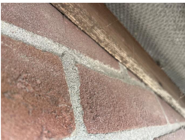
Afwerking van de golfplaten op de buitengevel van de ligboxenstal.
