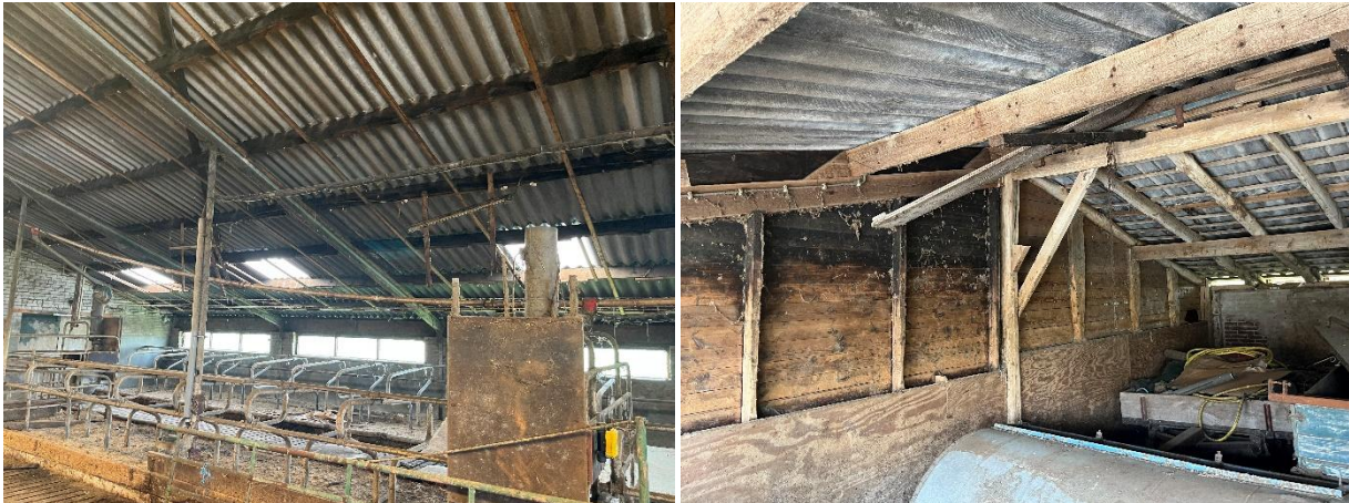
Aanzicht op de ligboxenstal (links) en potstal (rechts). De gebouwen beschikken niet over dakisolatie.
