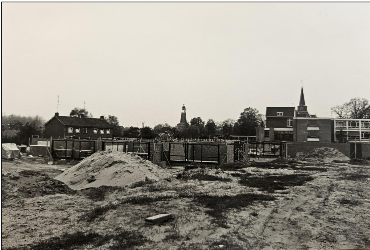
Figuur 8: Dit figuur toont een foto gedateerd 1 mei 1980 van het scholencomplex in aanbouw.
