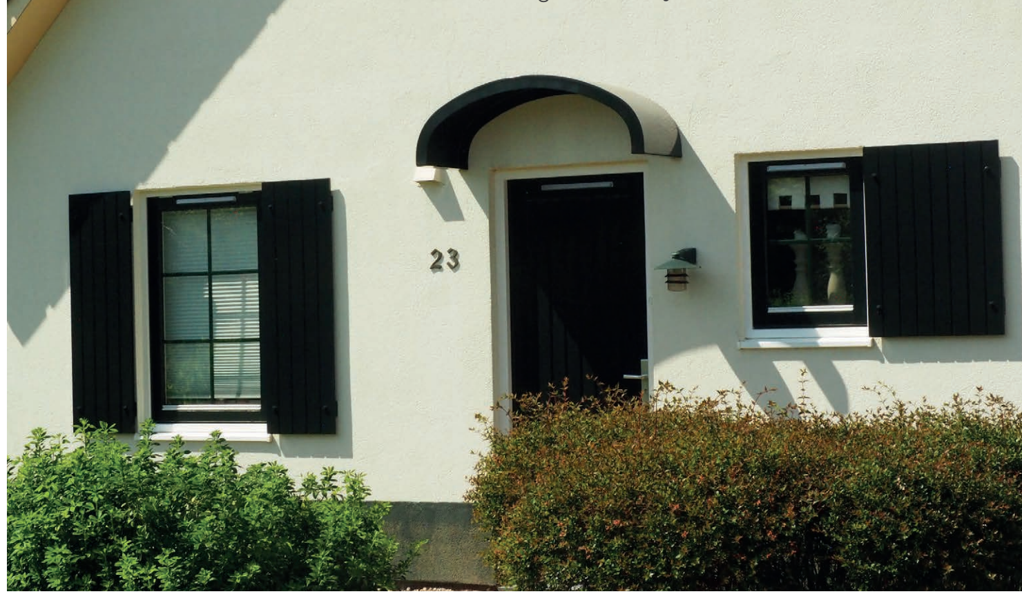
Oorspronkelijke luifel in de voorgevel en een enkel luik naast het vierkante raam.
