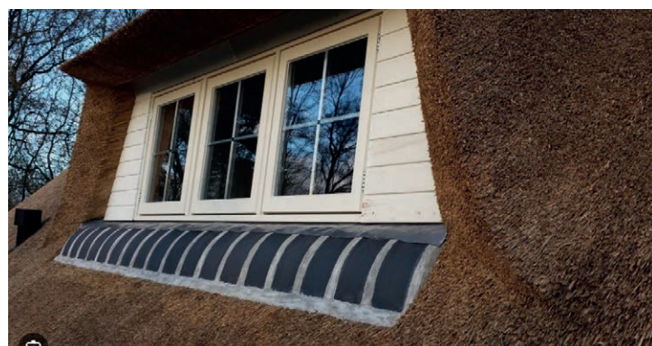
Dakkapel in uitvoering met riet
