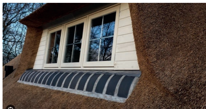
Dakkapel in uitvoering met riet
