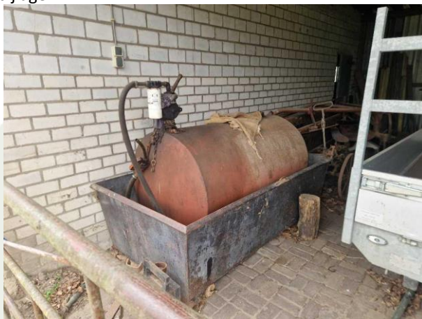
Figuur 11: Bovengrondse dieseltank
