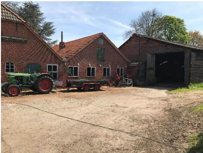
Figuur 7: zicht op het (achter)erf met uiterst rechts de te slopen voormalige koeienstal
