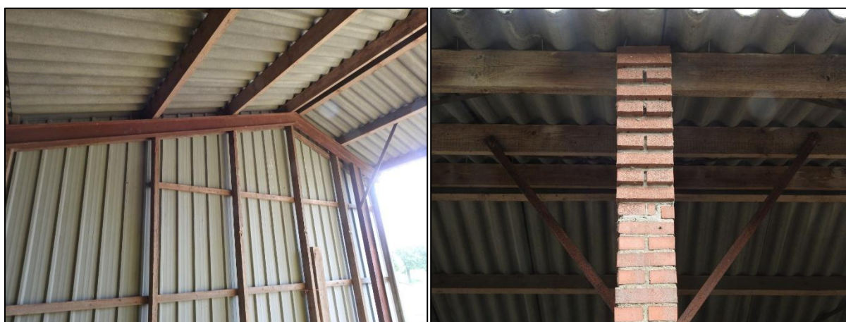
Figuur 10. Links: de metalen of houten geveldelen van schuur 1 zijn enkelwandig en bieden hierdoor geen beschutten plaatsen die vleermuizen kunnen gebruiken als verblijfplaats. Rechts: het metselwerk is uitgevoerd zonder spouw. Foto's: De Interim Ecoloog.
