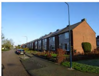
Figuur 2.3 Overzicht type woning aan de Juliana van Stolbergstraat en de Graaf van Lohnstraat.
