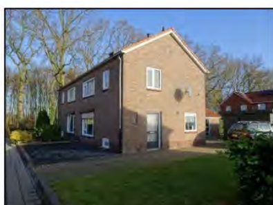
Figuur 7. Woningen aan de Haverstraat.
