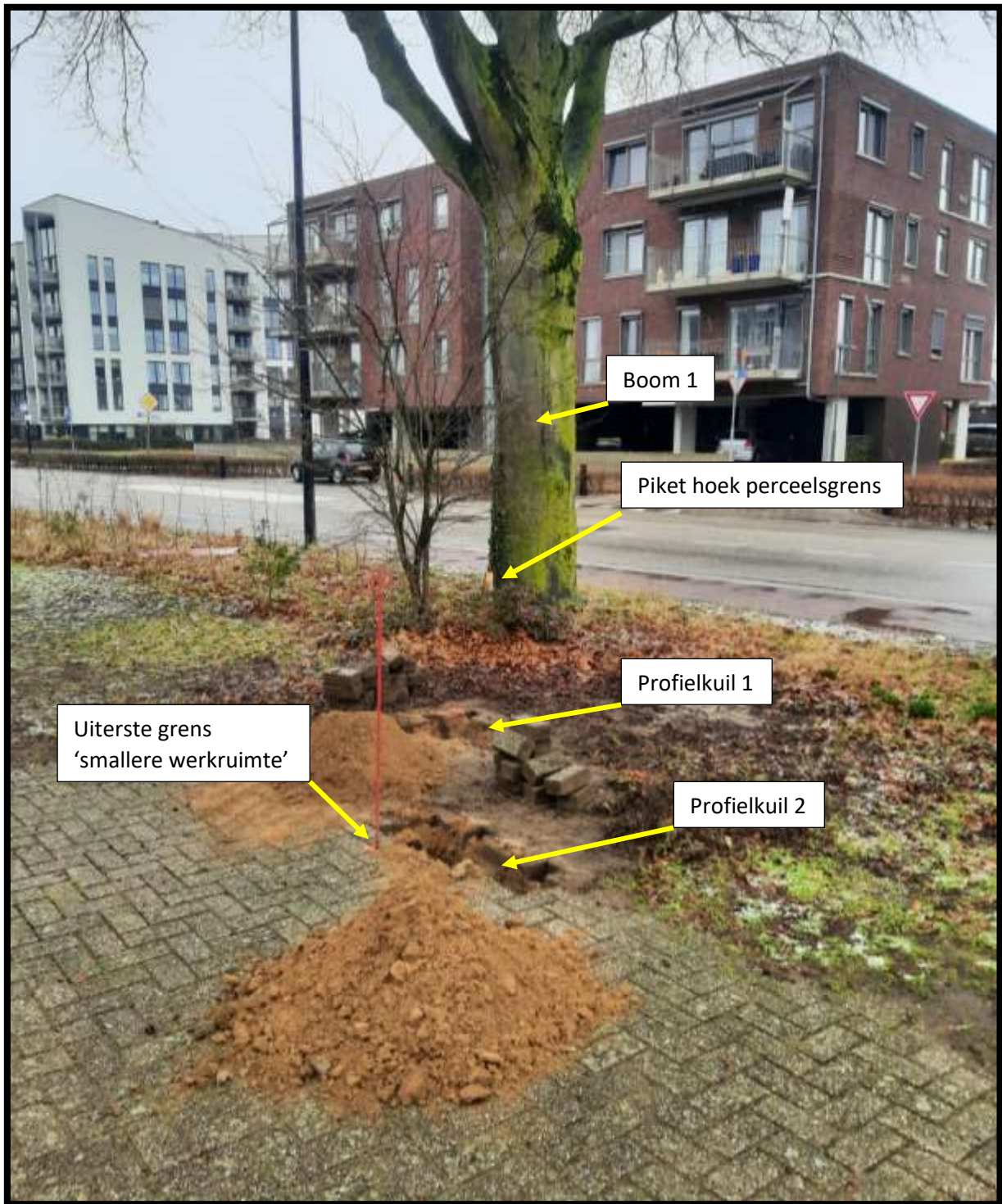
Foto 6, referentiepunten ondergronds onderzoek
