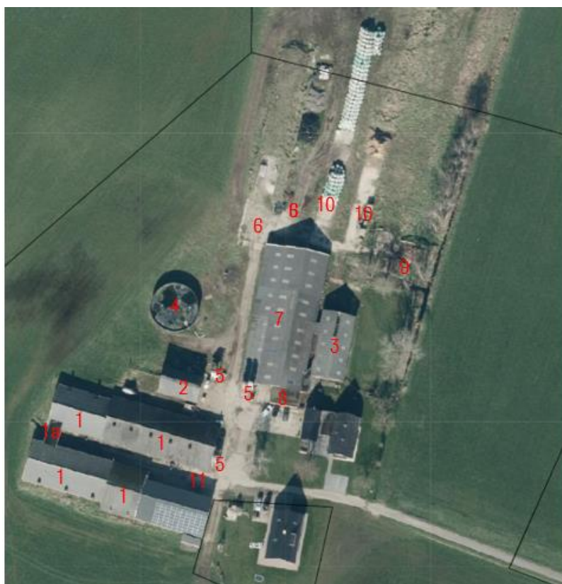
Figuur 1: luchtfoto met nummering te slopen bebouwing/te verwijderen opslagen
