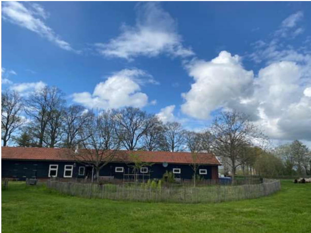
Afbeelding 1.7: Foto van de bestaande situatie/bebouwing, achtergevel inclusief de tuin.
