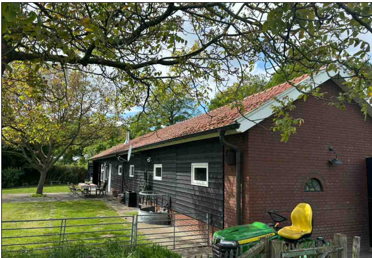
Afb. 6: Achterkant van de schuur op het perceel.
