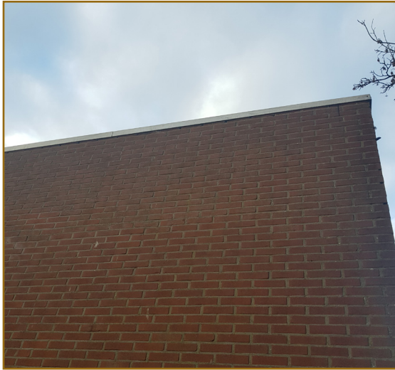
Afbeelding 2.7: De oostkant van de schuur. Onder de dakrand zijn er openingen aanwezig waardoor vleermuizen in de spouw kunnen kruipen.
