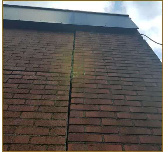
Afbeelding 2.8: Een dilatatievoeg in de schuur die toegankelijk is voor vleermuizen.
