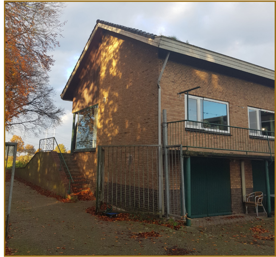
Afbeelding 2.2: Overzichtsfoto van de woning vanaf de oostkant. Ruimte voor huismussen onder de dakpannen.
