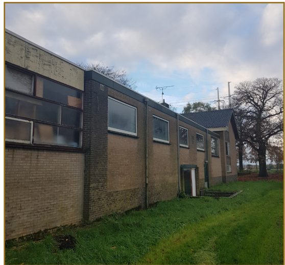
Afbeelding 2.4: Overzichtsfoto van de noordkant van de schuur.
