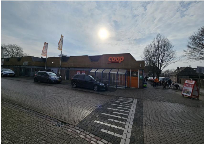
Figuur 4: Noordgevel gezien vanuit het noordwesten
