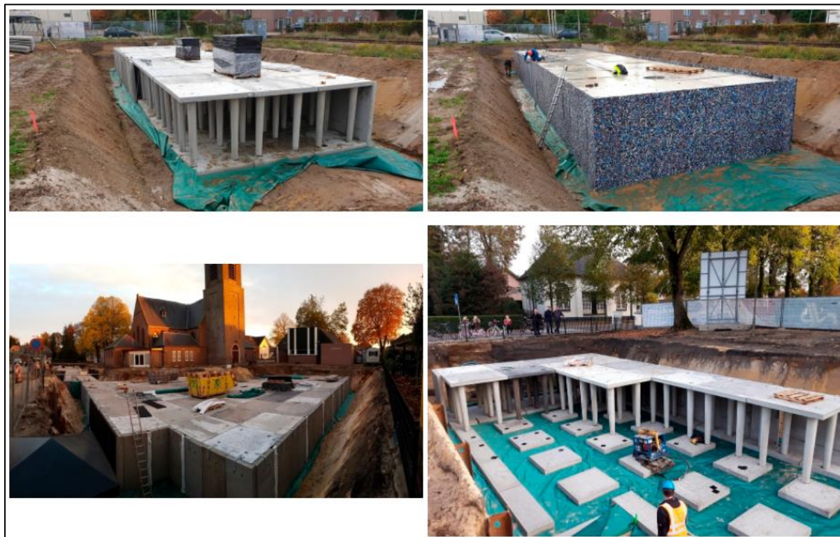
Figuur 6.1 Impressie watertable® systeem (bron: www.trewatin.nl )
