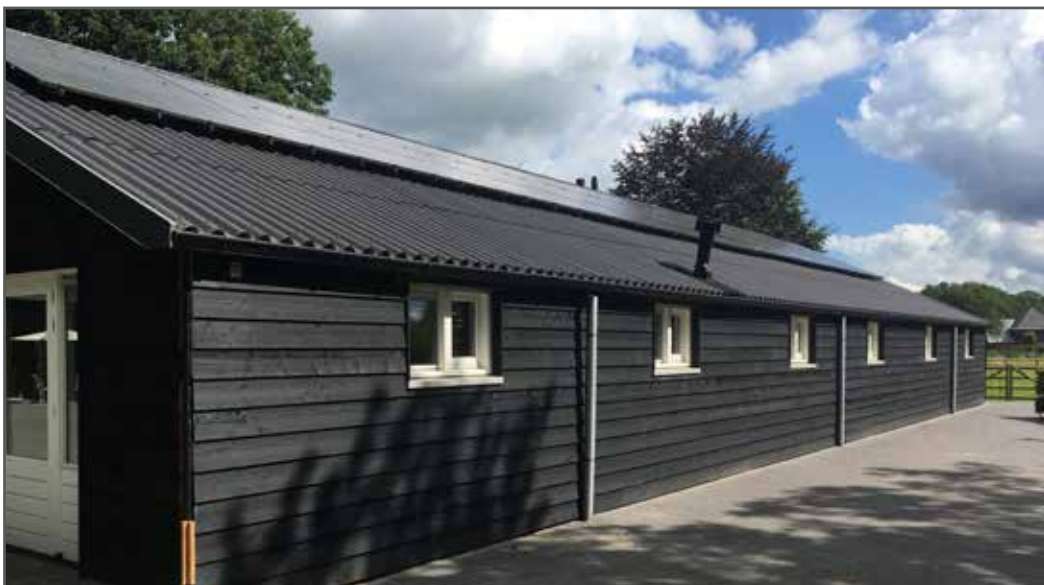
Foto: de verbouwde schuur aan de zuidzijde.
