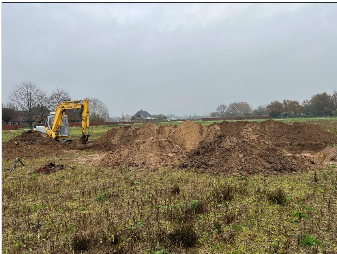
Afb.4 – Laagsgewijs detecteren en benaderen ter plaatse van de geschutstellingen "Uift – Biezenakker".
