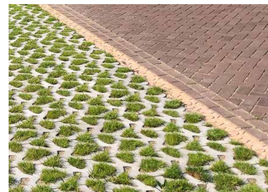
Grasbetontegels langs een straat
