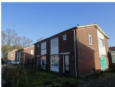
Figuur 2.4 Woningen aan de Haverstraat.
