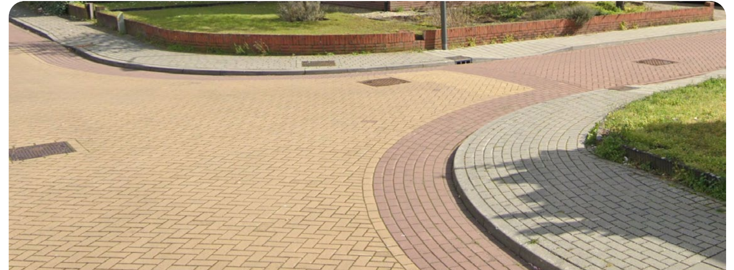
Rijbaan parkeerkoffer en trottoirs aansluiten op bestaand (foto Essenkampstraat). Vrijkomende bestrating hergebruiken.
