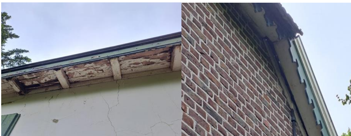
De betimmering van het dakoverstek sluit naadloos aan.
