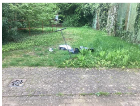
Foto 7 | foto voor boring 13-5
