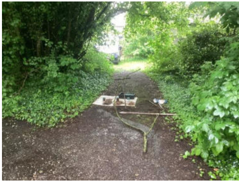
Foto 17 | foto voor boring 13-11
