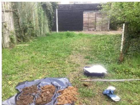
Foto 1 | foto voor boring 13-2
