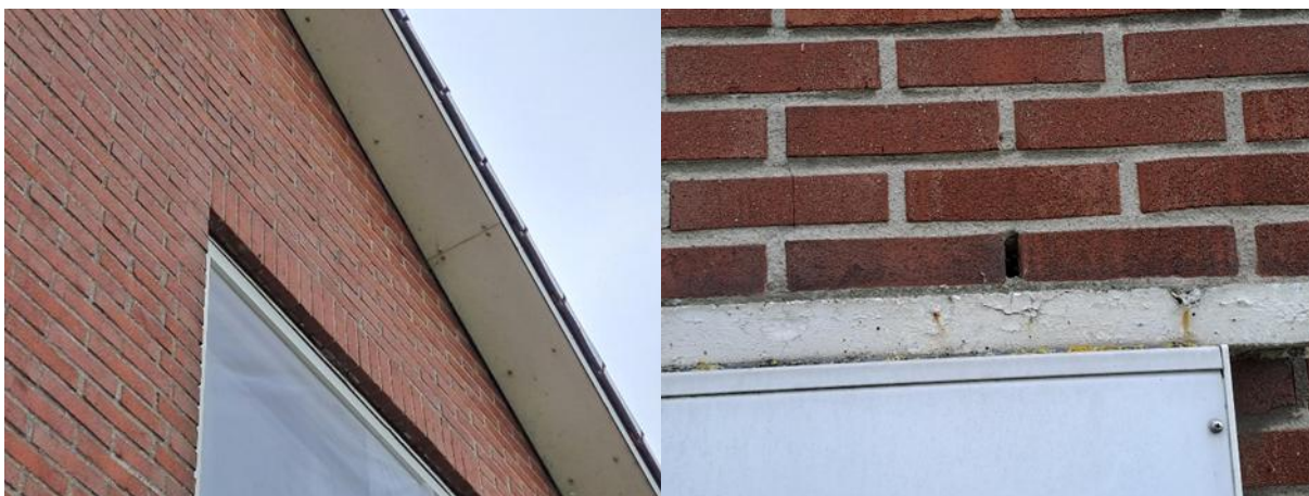
Foto links; de betimmering van het dakoverstek van de woning sluit niet naadloos aan op de buitengevels. Foto rechts; open stootvoegen in het metselwerk van de woning.
