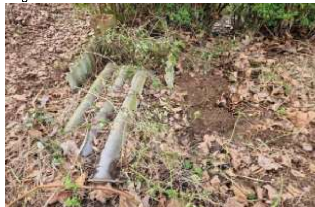
Figuur 11: Asbestverdacht materiaal
