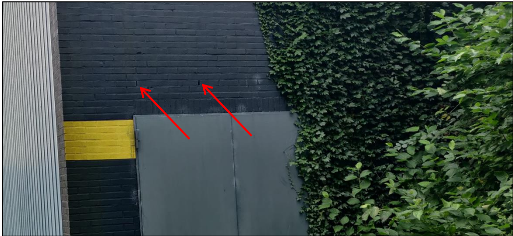
De bebouwing op het bedrijventerrein bevat naast andere mogelijkheden ook enkele open stootvoegen.
