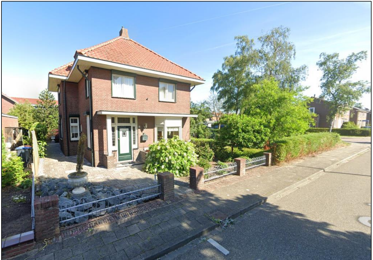
Figuur 4 locatie gezien vanaf Schoolstraat (bron: Google maps)
