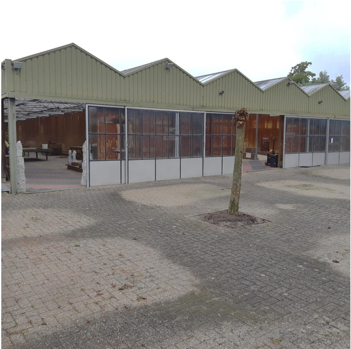
Afbeelding 15: Foto van de achterzijde van de kas van het tuincentrum genomen richting het noorden.
