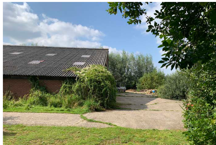
Betonplaten rondom oude loopstal
