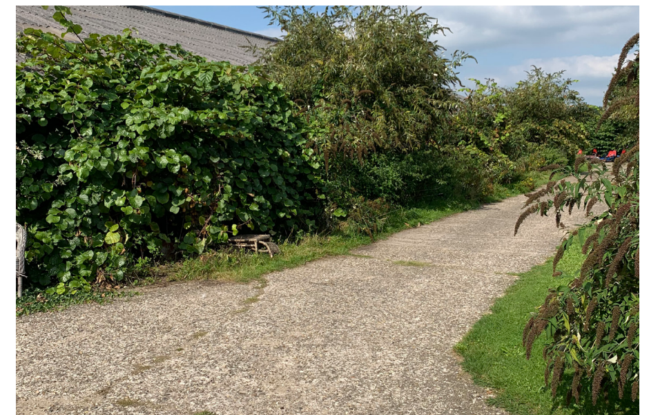
Betonplaten tussen oude loopstal en schuur verblijfsrecreatie
