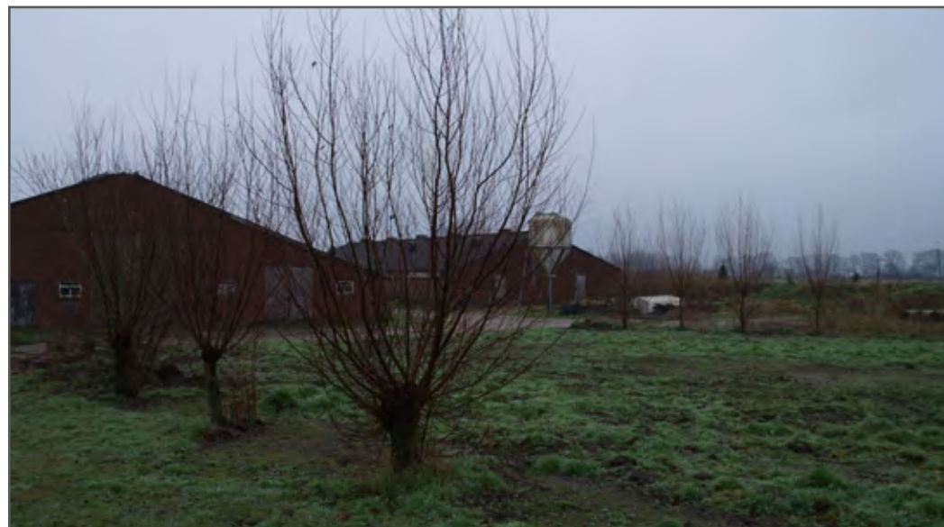
Foto: te slopen stallen
