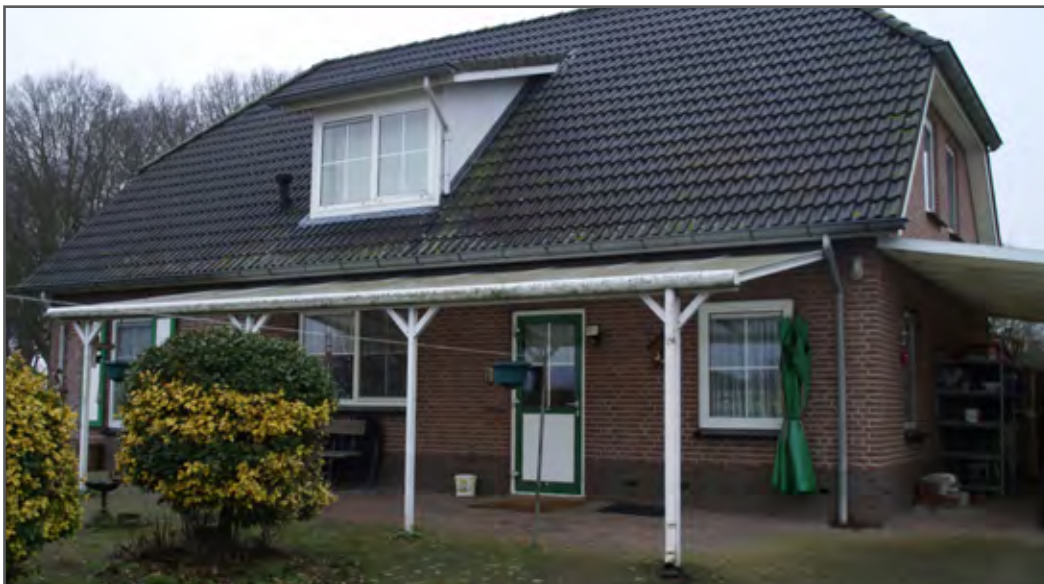
Foto: Bestaand woonhuis
