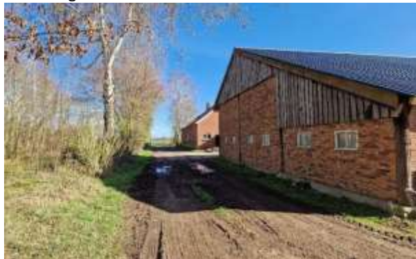
Figuur 12: Puinpad + nieuw dak asbestverdacht schuur.
