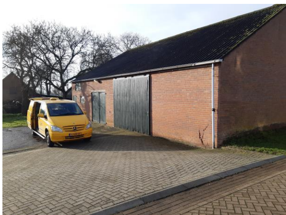
Foto 3: Schuur op de locatie met de klinkerverharding en asbestverdachte dakbedekking met dakgoot.
