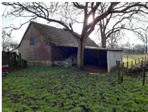
Foto 8: Voormalige stal op de locatie, gezien in zuidelijke richting. Dakbedekking bestaat uit dakpannen.
