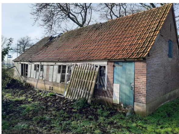
Foto 9: Voormalige stal op de locatie, gezien in westelijke richting.
