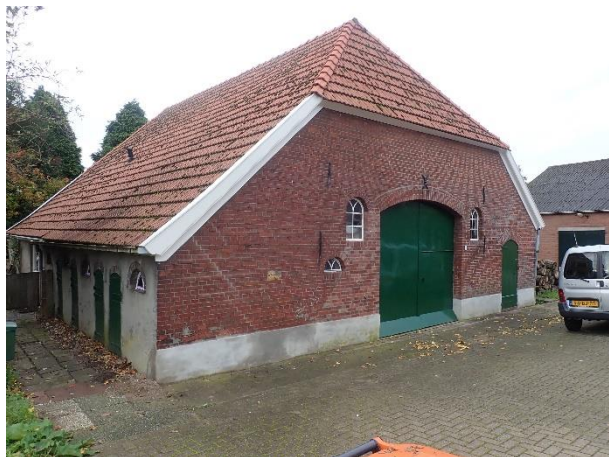
Foto 1: links, het woonhuis vanaf de straat gezien.
