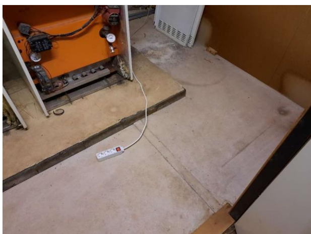
"Nieuwe" brandwerende beplating ketelruimte 1e verdieping gebouw 1
