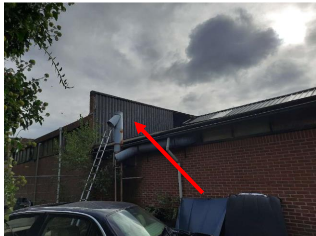
Overzicht gevelbeplating (deels) gebouw 3
