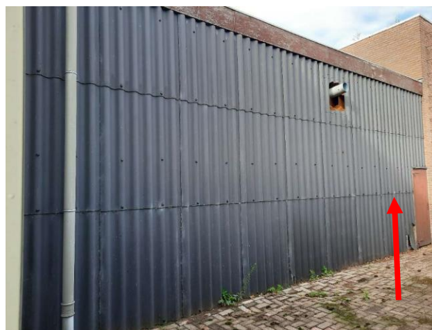
Situering MM04 en overzicht golfplaten zijgevel (deels) gebouw 3
