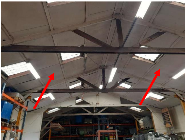
Overzicht vlakke platen binnenzijde dak gebouw 2
