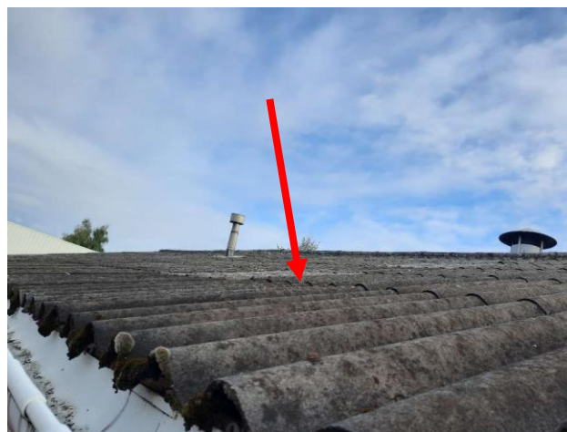
Golfplaten en nokstukken dak gebouw 2
