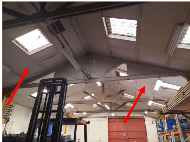
Overzicht vlakke platen binnenzijde dak gebouw 2
