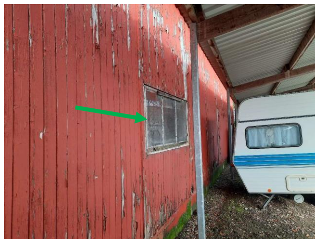
Stopverf draadglas achtergevel gebouw 2
