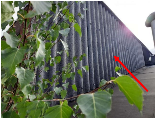
Overzicht gevelbeplating (deels) gebouw 3
