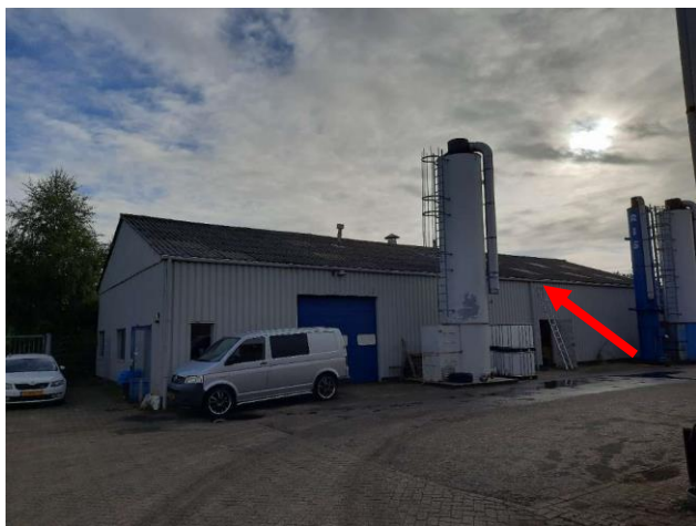
Situering MM02, golfplaten en nokstukken dak gebouw 2
