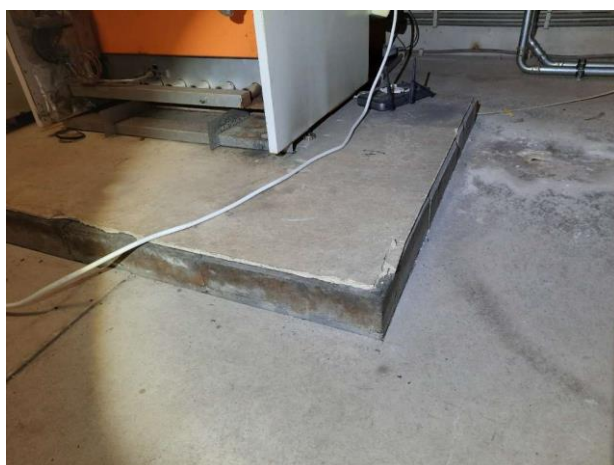
"Nieuwe" brandwerende beplating ketelruimte 1e verdieping gebouw 1
