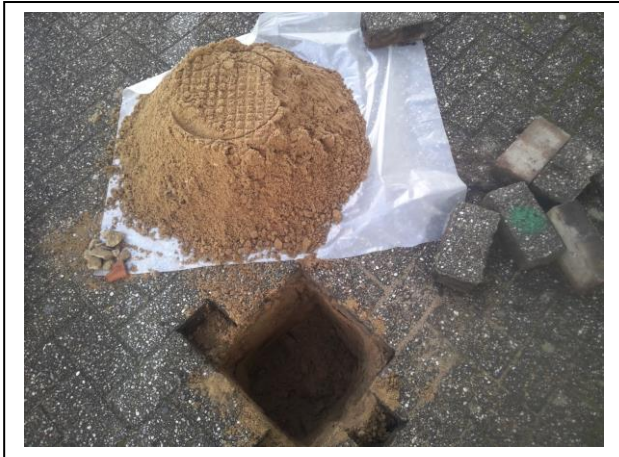
Foto 7. Asbestinspectiegat G02-A
