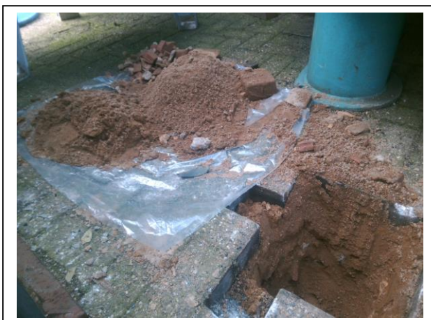
Foto 17. Asbestinspectiegat I01-A
