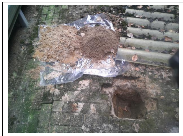
Foto 6. Asbestinspectiegat E02-A
