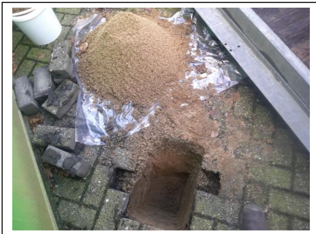
Foto 9. Asbestinspectiegat G04-A
