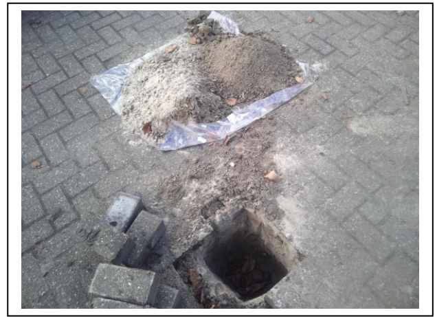
Foto 16. Asbestinspectiegat H02-A
