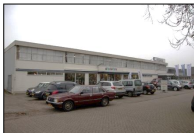
Figuur 3. Zuidwestzijde bebouwing.
