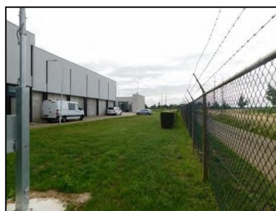
Figuur 7. Zuidwestzijde onderzoekslocatie.
