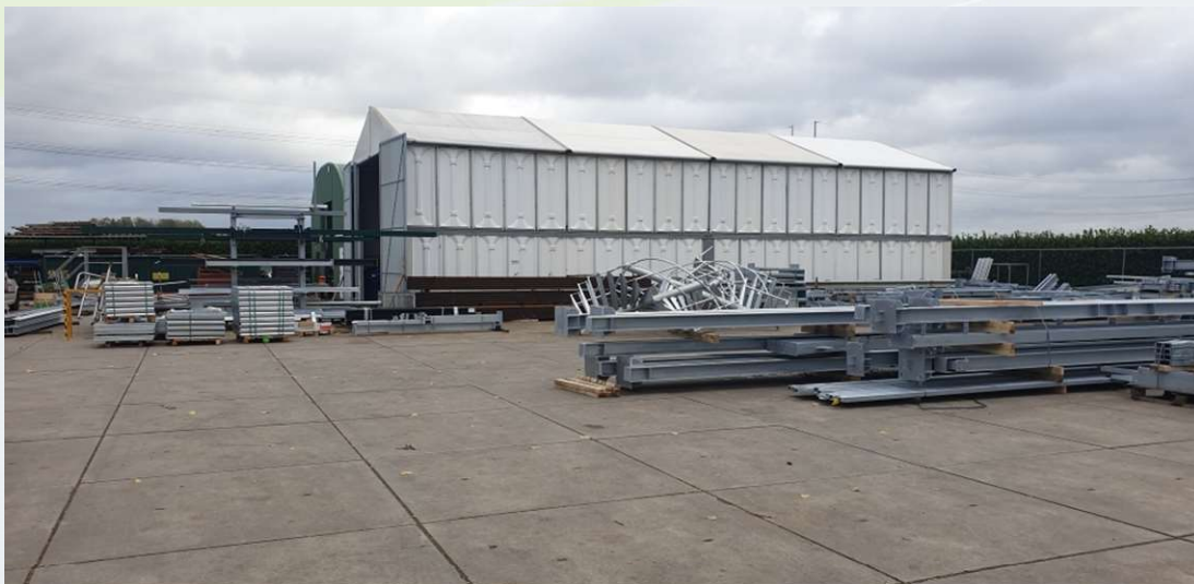
Zicht op het plangebied, de tijdelijke montage-tent en de Romney-loods
